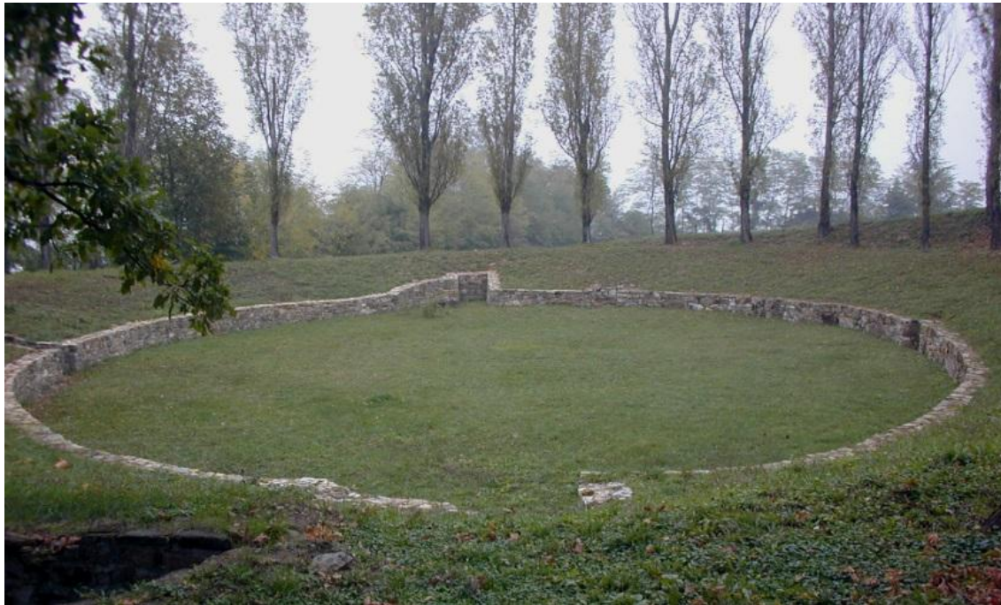
22. Il "Cisternone" di Veleia, struttura in origine circolare: « castellum aquae » o «anfiteatro»?
