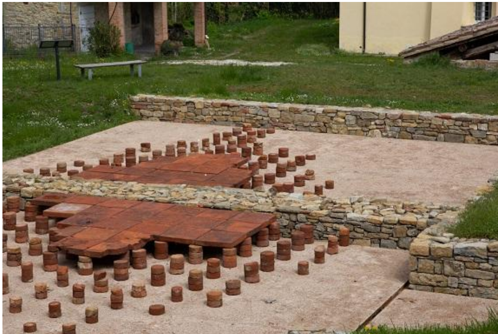
Pavimento a suspensurae del complesso termale a sud-ovest del Foro di Veleia
